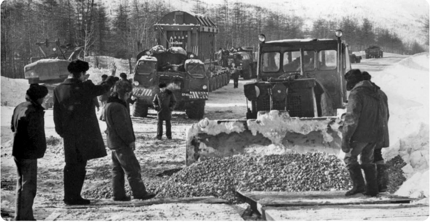
Доставка по Колымской трассе 180-тонного трансформатора для Колымской ГЭС. 29.02.1980. Магаданская область
