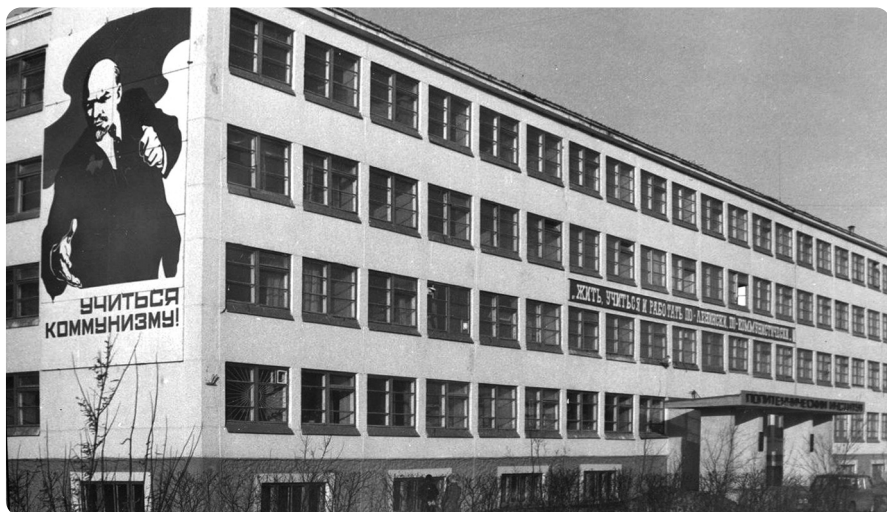
Здание Магаданского филиала Хабаровского политехнического института (ныне – Политехнический институт Северо-Восточного государственного университета), 1985
