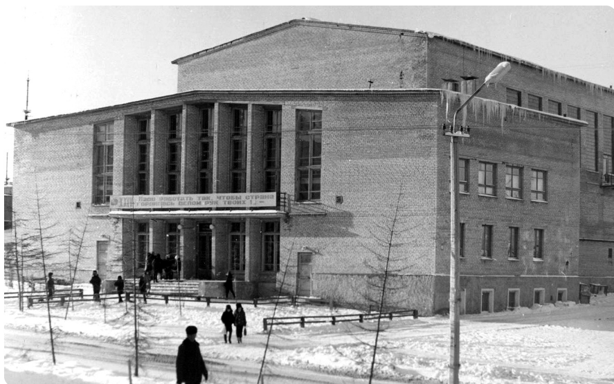
Магадан. Здание городского плавательного бассейна, 1985
