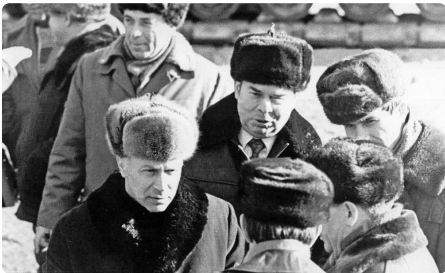
На строительстве Всесоюзной ударной комсомольской стройки – Кольмской ГЭС. 04.02.1981
